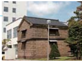
1911年開館、1916年2階増築、北海学園図書館北駕文庫(現1号棟)
